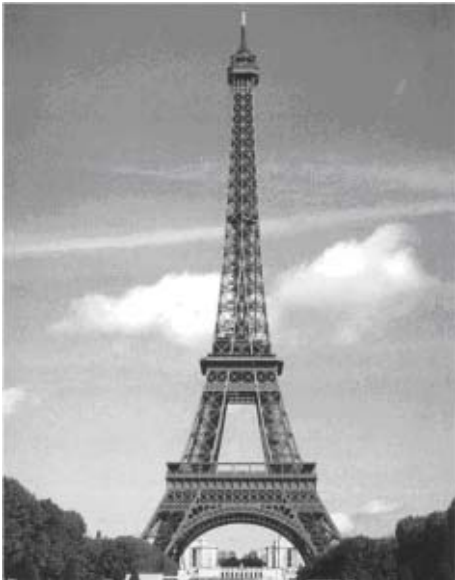
Fig.10 – Tour Eiffel, costruita in occasione dell'Esposizione Universale del 1900 e composta da 18038 travetti rivettati in acciaio
