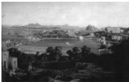
Fig. 8 – Francesco Mancini, I lavori di apertura del porto (1853)
