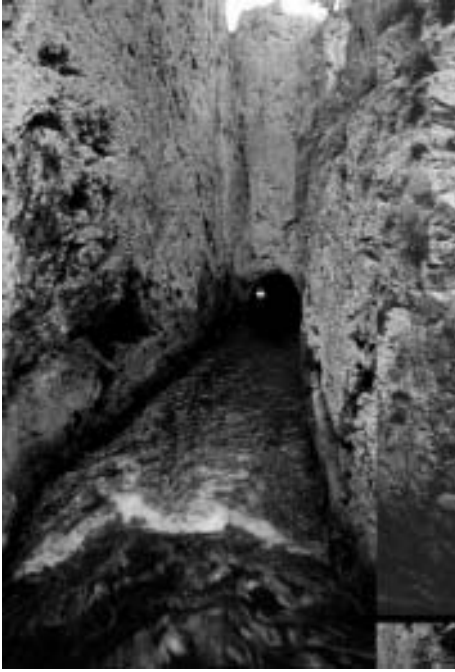
Fig. 6 – La “Tagliata” etrusca, canale di drenaggio dell’antico porto di Cosa (Ansedonia) perfettamente scavato nella roccia
