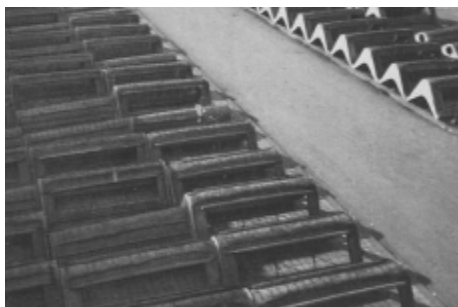
Fig. 6 – Elementi prefabbricati per la volta del Salone di Torino Esposizioni
