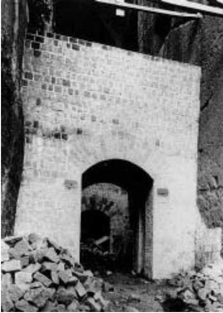
Fig. 6 – I setti di contrasto in muratura annegati nel rinterro del 1930
