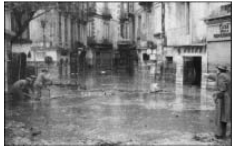
Fig. 4 – Zona Massa: danni provocati dall'alluvione del 24 novembre 1959
