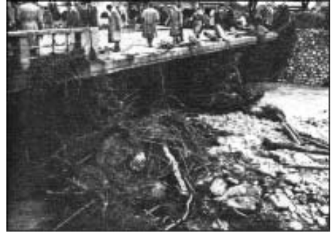
Fig. 3 – Ostruzione Ponte S. Lorenzo del 24 novembre 1959
