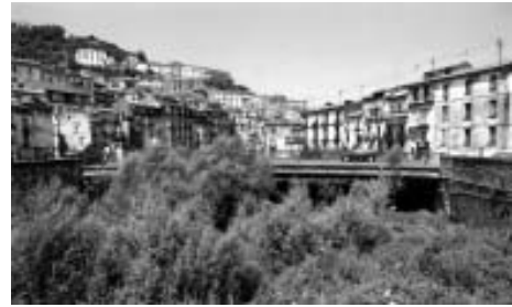
Fig. 11 – Criticità del Ponte S. Lorenzo
