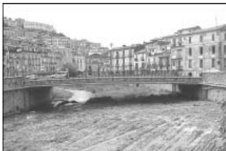
Fig. 9 – Stato attuale del Ponte S. Lorenzo
